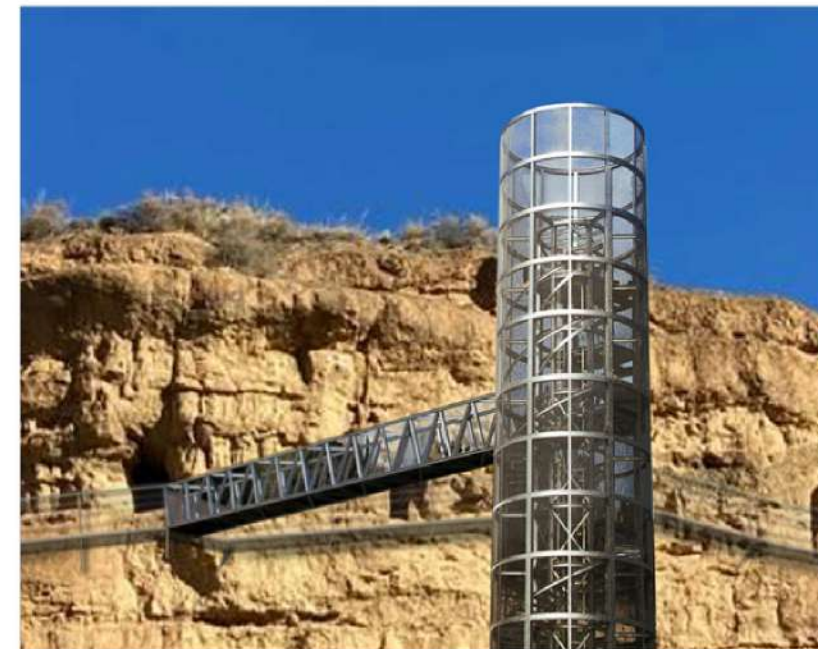
ORTOFOTO 2 ASCENSOR PANORÁMICO
