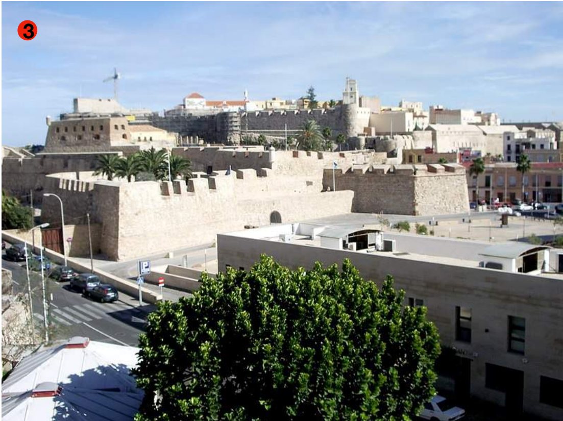
Cuarto Recinto Fortificado
