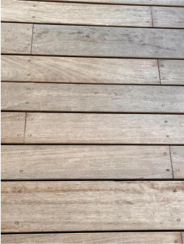
lamas de madera separadas por llagas para evacuar aguas pluviales
